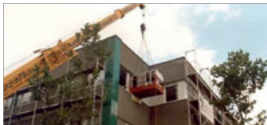
доставка краном h/p/cosmos saturn®
